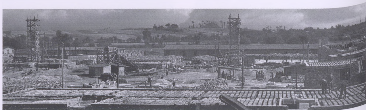
Na placu budowy Nowej Huty (osiedle A-1). Mogiła, lato 1949 r. fot. Stanisław Senisson/A.G.
