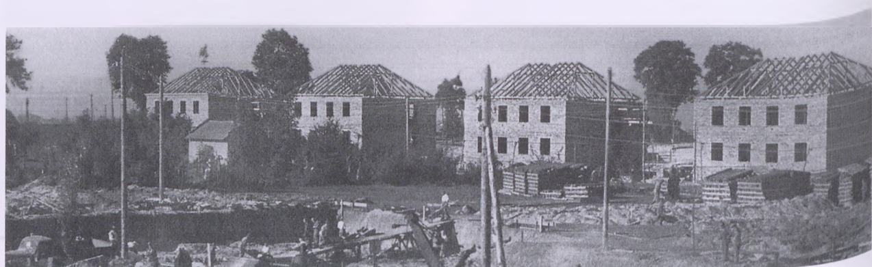
Na placu budowy Nowej Huty (osiedle A-1). Z lewej strony widoczny cmentarz w Mogile, 1949 r., fot. inż. arch. Jan Unger. Archiwum „Głosu”
