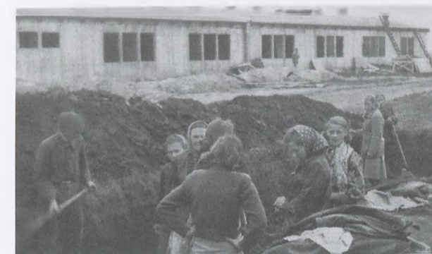
Wykopiska w Pleszowie, w tle baraki tzw. „Meksyk”. ok. 1958 r.
