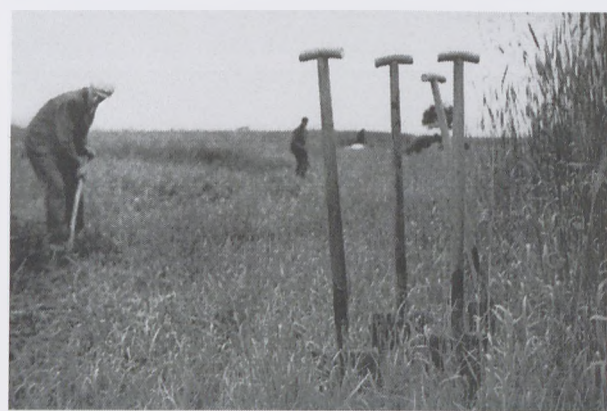
Wbieganie pierwszych łopat na budowie Nowej Huty, 22 czerwca 1949 r. Archiwum „Głosu – Tygodnika Nowohuckiego”
