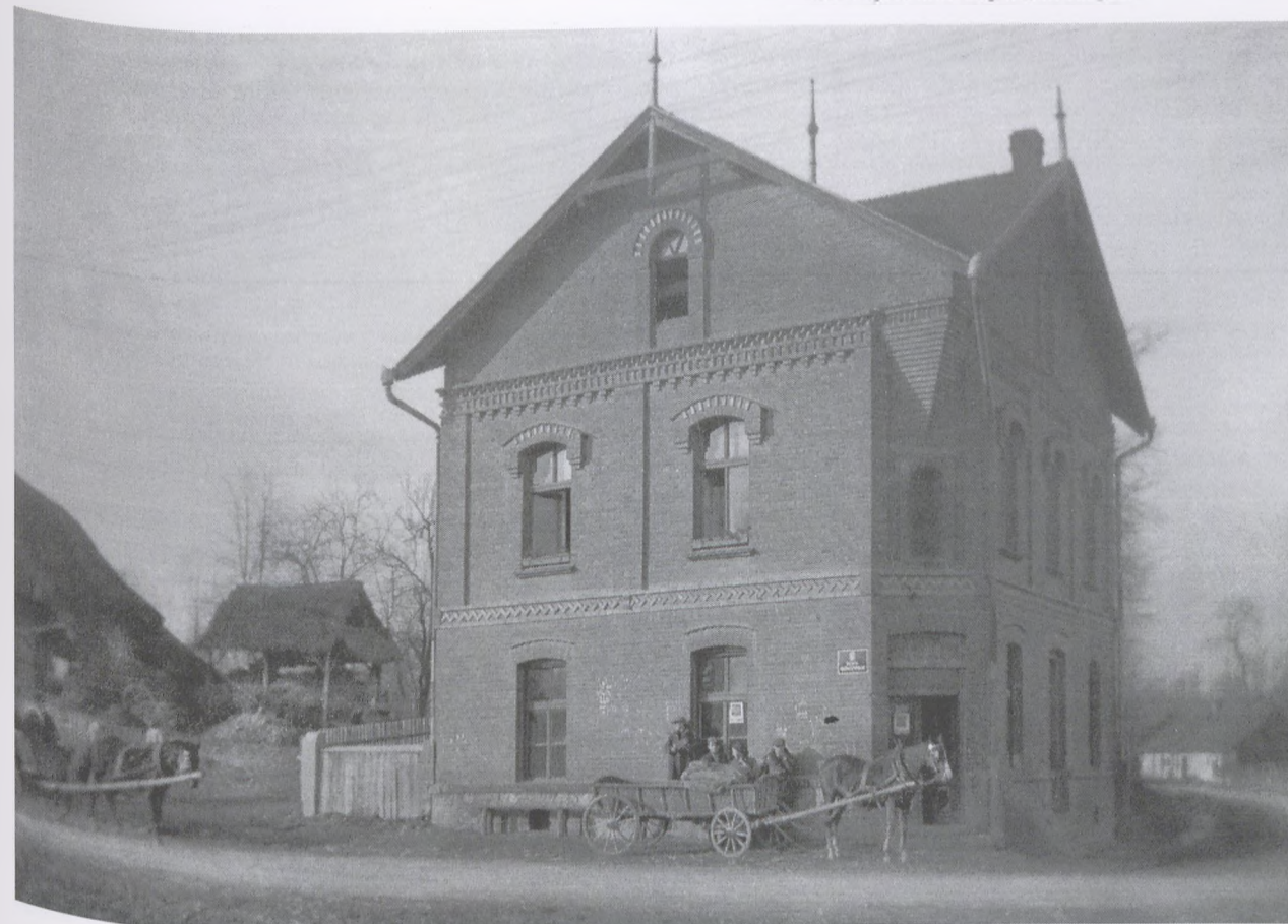
Budynek „Sokoła” w Bieńczycach, lata 20. XX w.
