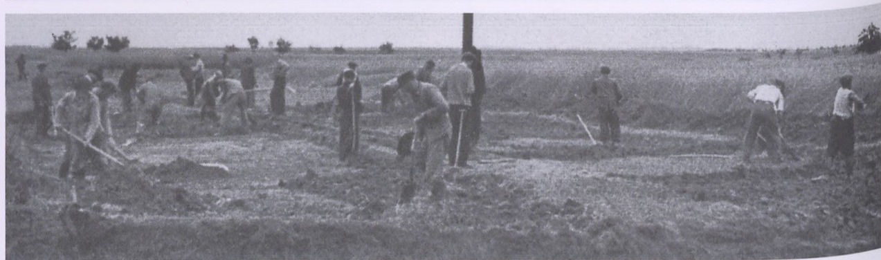
Rozpoczęcie prac ziemnych pod budowę osiedli mieszkaniowych Nowej Huty. Mogiła, czerwiec 1949 r. Archiwum „Głosu – Tygodnika Nowohuckiego”
