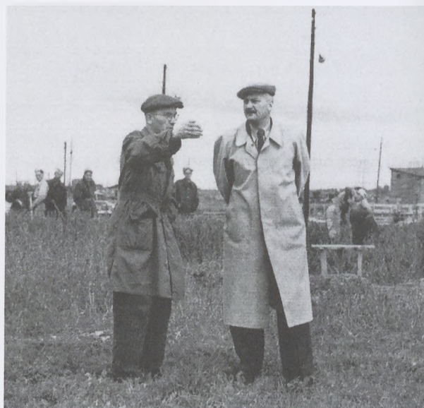
Z prawej inż. Jan Aniela, dyrektor kombinatu HIL na placu budowy, 1952 r.
